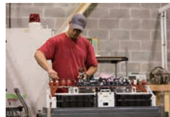
TOYO DENKI USAでの組立風景 (2015年)
