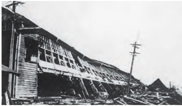
関東大震災で倒壊した横浜工場 (1923年)
