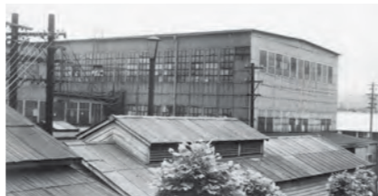
火災後に新築した機械工場 (1926年)
