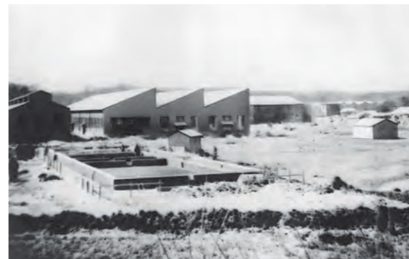
建設中の戸塚工場(1939年)
