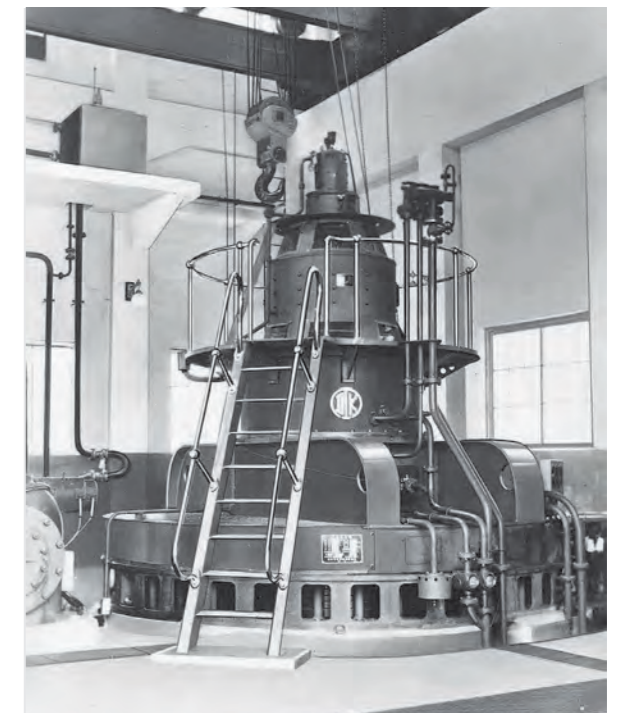
1,250kVA たて形水車発電機 (1954年 鷹栖農協鷹栖発電所納入)
