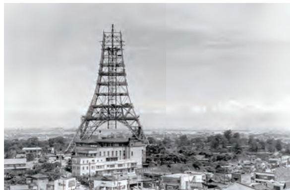
建設中の東京タワー（1958年 資料提供：毎日新聞社）
