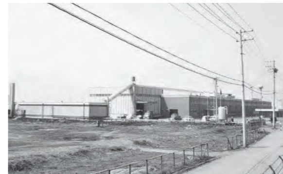
建設中の相模工場（1969年ごろ）
