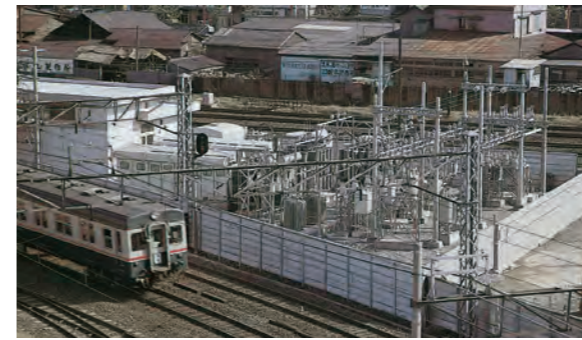
1,500V 2,000kVAシリコン変電設備（1961年 相模鉄道納入）
