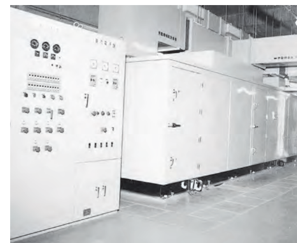
2,000kVAガスタービン発電装置 (1981年 国鉄盛岡駅納入)
