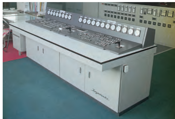
本庄市第2浄水場集中管理システム (1980年)
