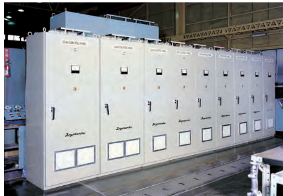
空調設備用インバータ装置 (1981年 新宿三井ビル納入)
