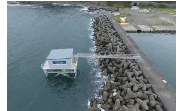
当社パワーコンディショナ盤を納入した久慈波力発電所 (2017年)
