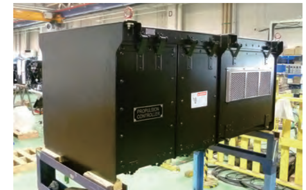
タンパ国際空港APM向け主制御装置(2018年 三菱重工業納入)
