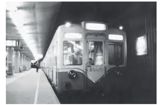
回生ブレーキの試験車両外観 (1969年 都営地下鉄1号線)
