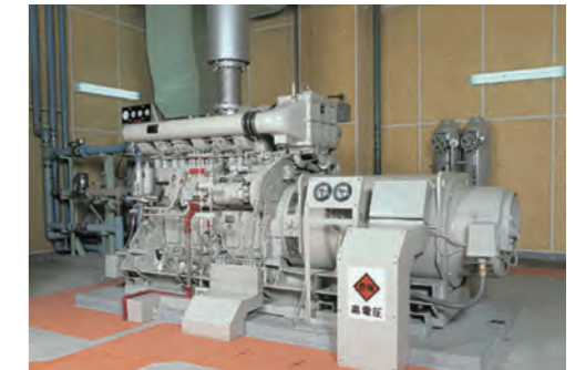
常用発電装置
