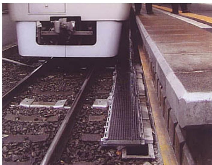
最大の特徴は、動作が非常に安定し、信頼性の高い検知マットを使用している点です。仕様は、セーフティマットとして国際規格をクリアし、1枚が幅35cm長さ150cmの大きさのマットをホーム下に敷設することにより、転落を検知することができます。3月下旬、京王電鉄の井の頭線・下北沢駅に採用されました。
