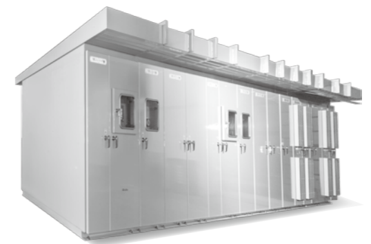
回生電力貯蔵装置「E 3 Solution System」 / 日野変電所 定格容量 2,000kW
